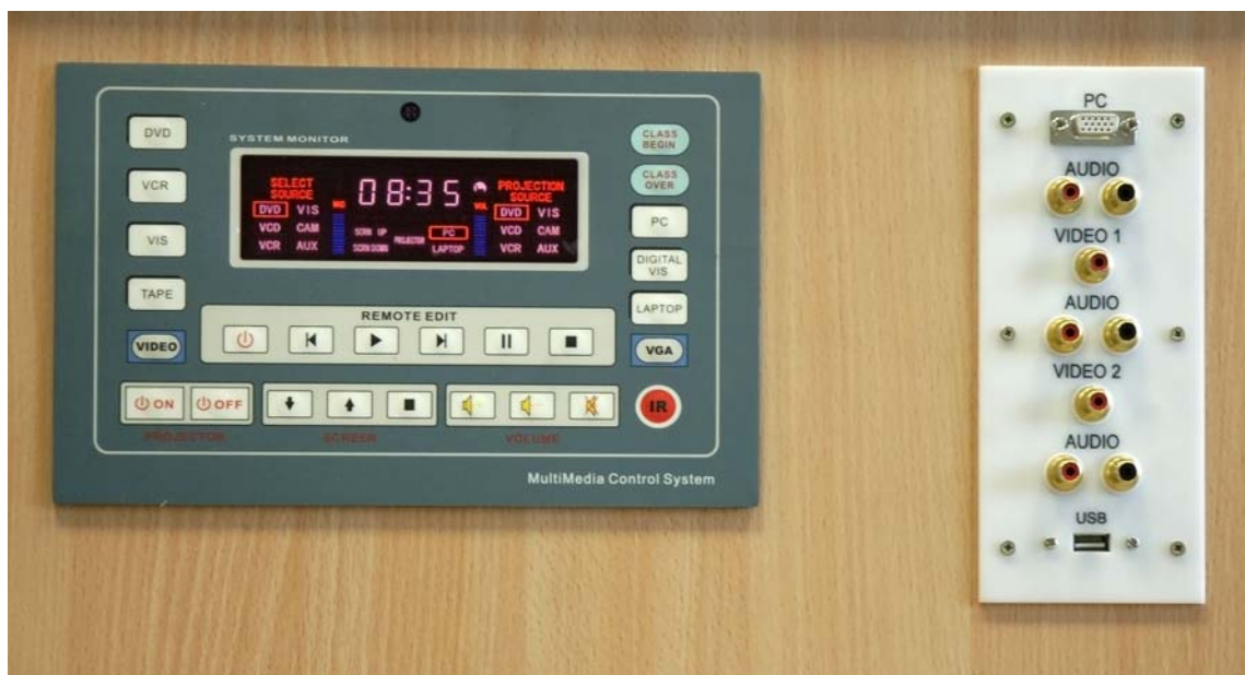
WIDOK PULPITU STEROWANIA ( JEDNOSTKA CENTRALNA I GNIAZDA PRZYŁĄCZENIOWE)
